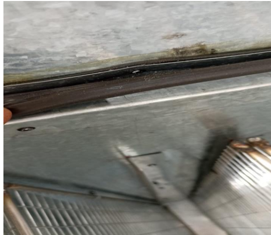
Figura 39 Colocación de caucho térmico
