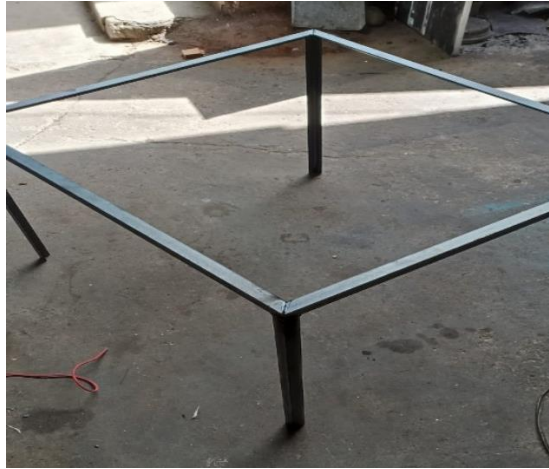
Figura 33 Colocación de la base.
