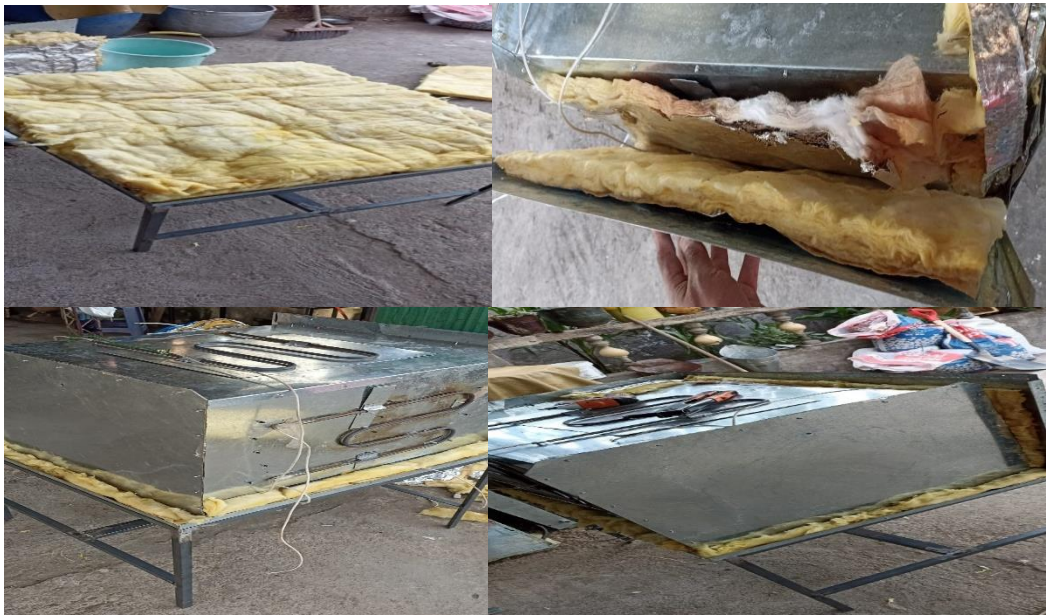
Figura 37 Colocación de lana de vidrio.
