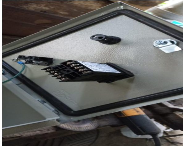
Figura 41 Implantación de termocupla y selector.
