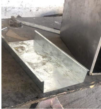
Imagen 7: Construcción entrada de aire
