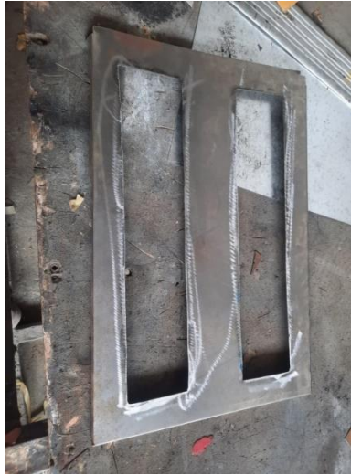
Imagen 5: Construcción fosas piso
