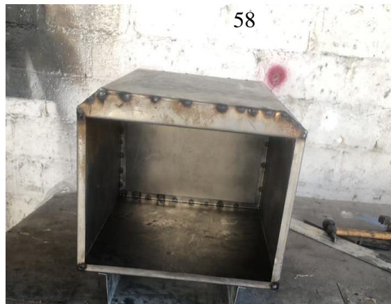
Imagen 6: Construcción laterales y techo
