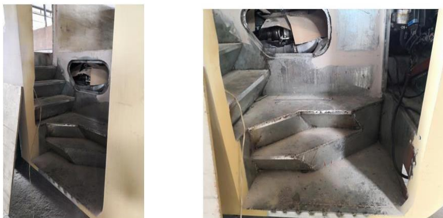
Imagen 11: Soldadura de gradas. Fuente: Carrocerías MegaSantaCruz.
