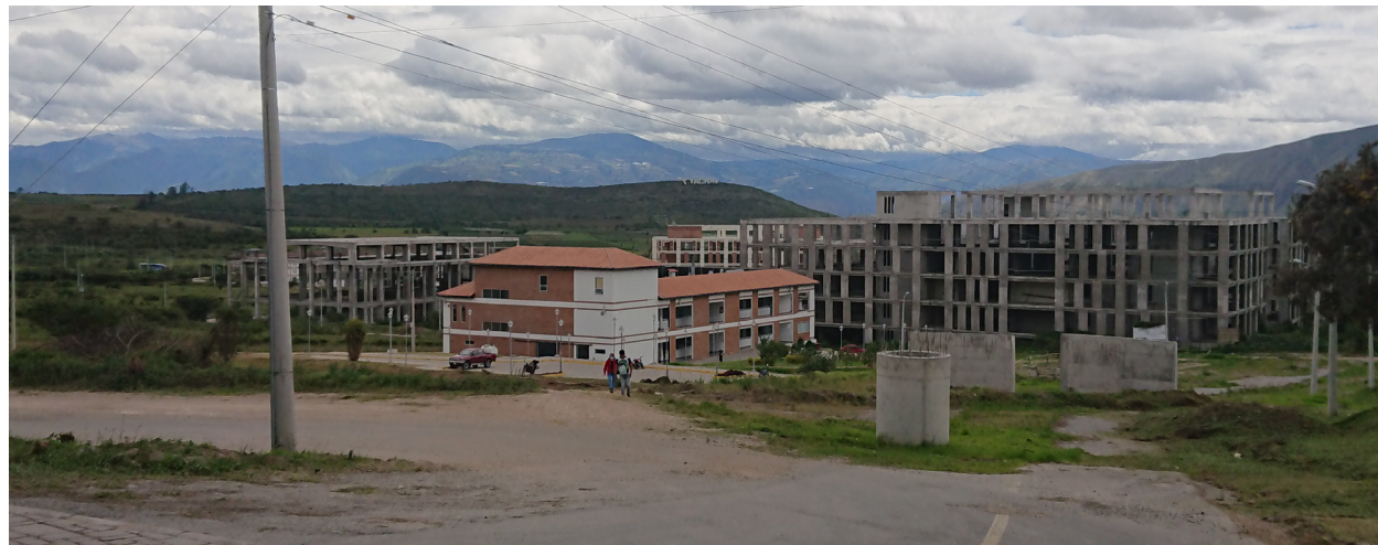
Figura 34: Espacios construidos CC Yachay. Centro de investigación y edificios en obra gris.
