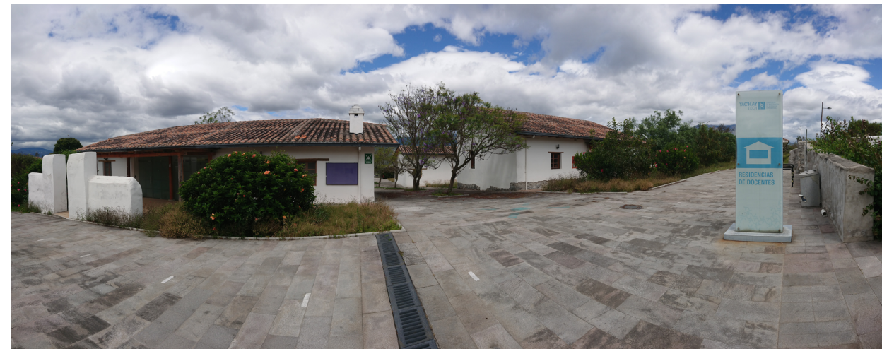
Figura 35: Espacios construidos CC Yachay. Residencia de docentes.
