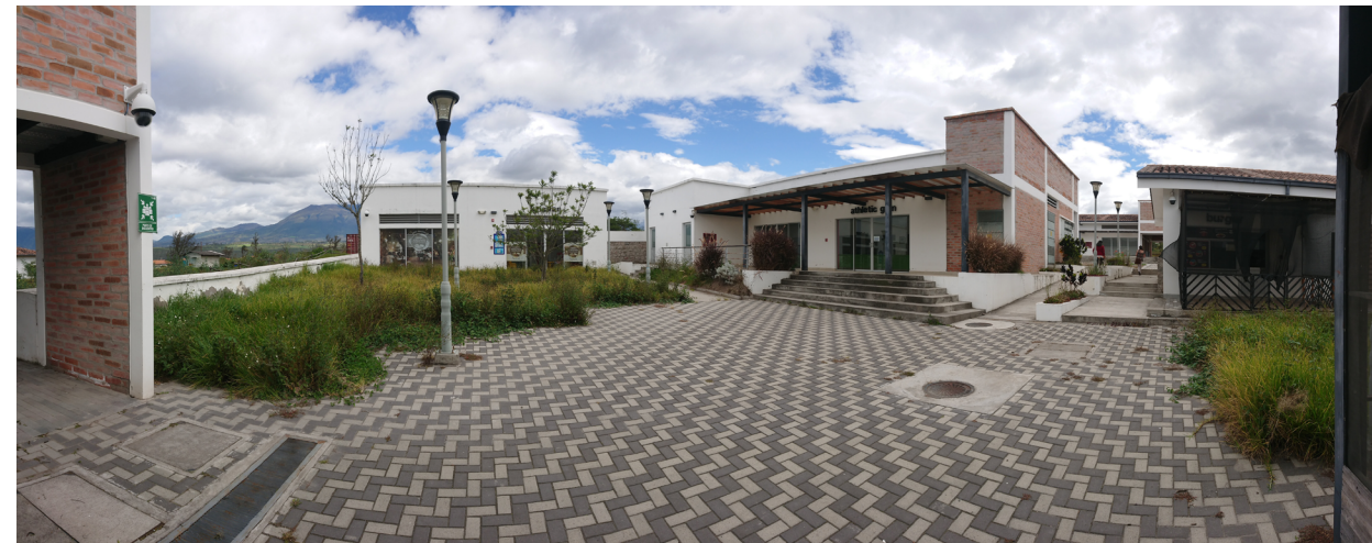
Figura 36: Espacios construidos CC Yachay. Restaurante y servicios (Mercado).
