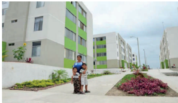
Figura 17: Vivienda multifamiliar. Fuente: Miduvi, 2019.
