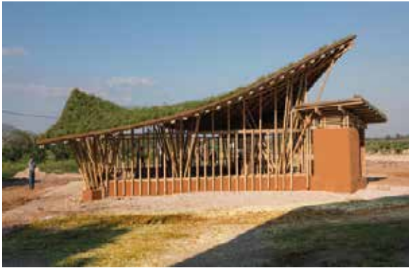
Figura 10: Estructura sustentable con materiales de bajo impacto Fuente: Lucila Aguilar Arquitectos (2016)
