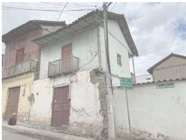
BALCONES EN FACHADA PRINCIPAL PERSPECTIVA
