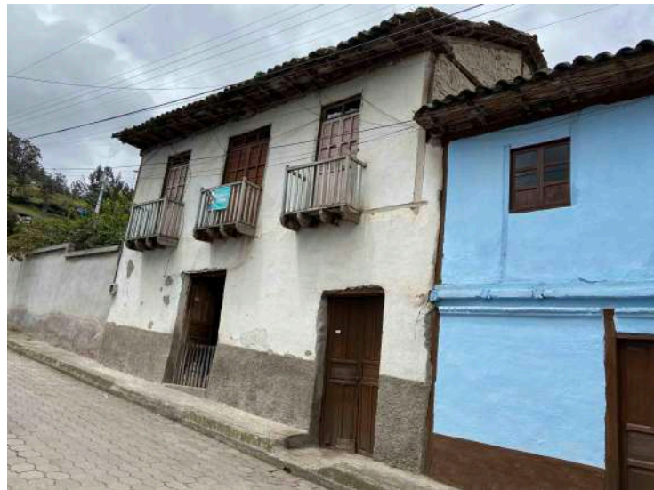
BALCONES EN FACHADA PRINCIPAL PERSPECTIVA
