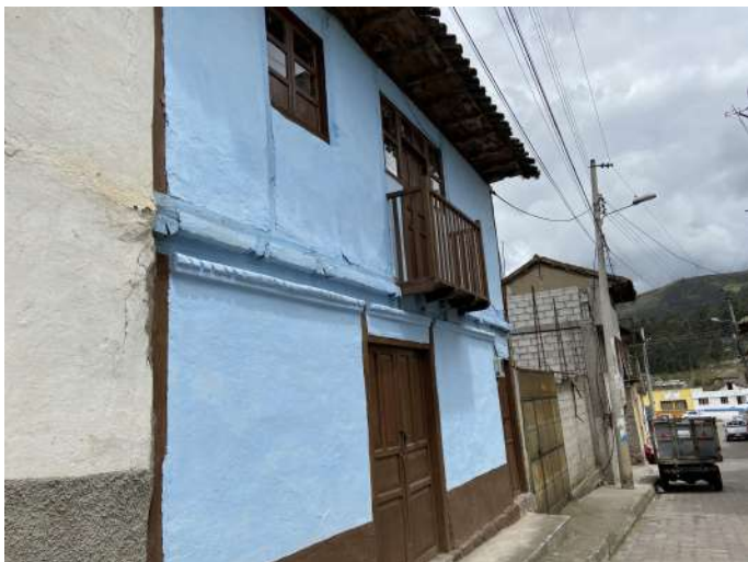
BALCONES EN FACHADA PRINCIPAL PERSPECTIVA
