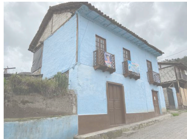
BALCONES EN FACHADA PRINCIPAL PERSPECTIVA
