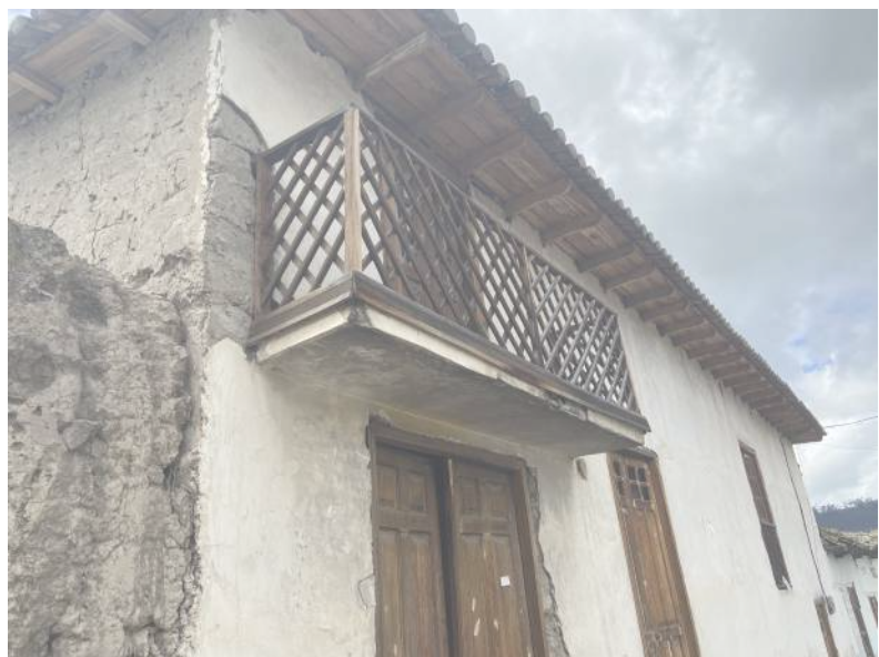
FACHADA PRINCIPAL BALCÓN EN FACHADA PRINCIPAL
