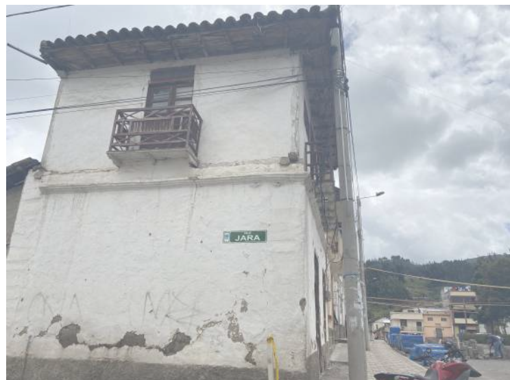
FACHADA LATERAL BALCÓN EN FACHADA LATERAL
