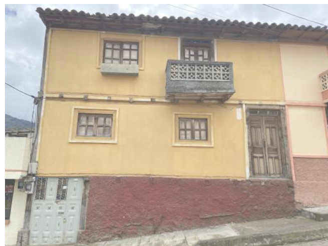
BALCONES EN FACHADA PRINCIPAL FACHADA PRINCIPAL
