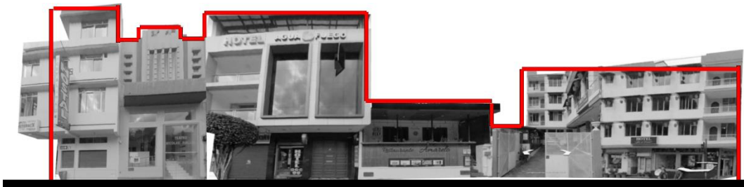
Gráfico 19. Calle Pedro Vicente Maldonado – Frente al parque Palomino Flores Fuente: Google Maps Elaborado por: Gabriela Lascano Marcos
