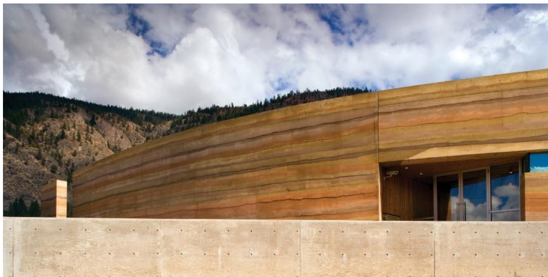
Figura 41. Muro de Tapial del Centro Cultural del desierto
