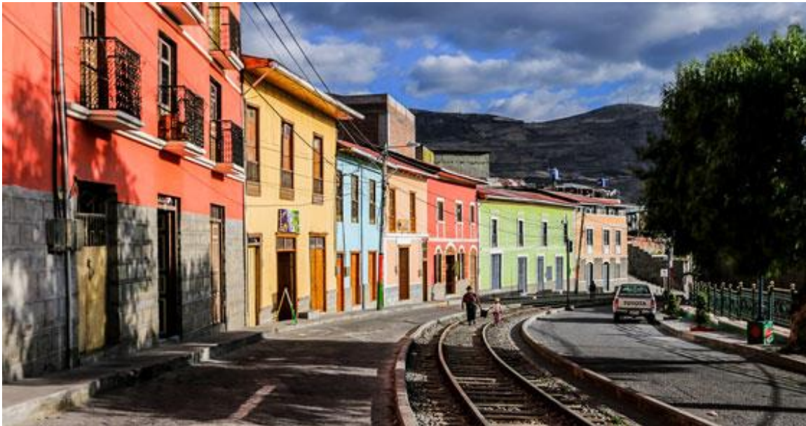
Figura 6. Fachadas viviendas patrimoniales.
