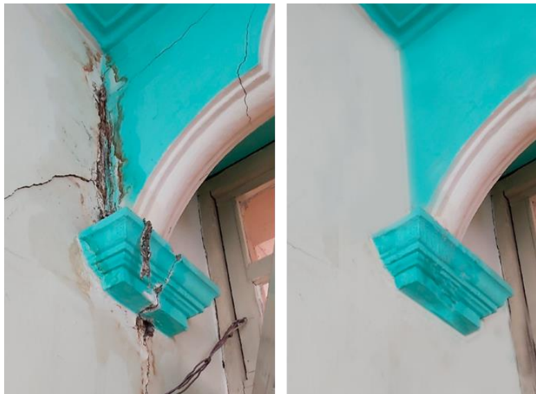
Figura 70. Saneamiento de revestimientos.
