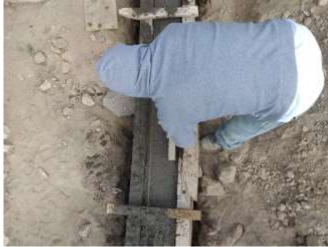
Figura 42. Medición del ángulo del cuello (Muro de cimentación) Elaborado por: Karen Villafuerte
