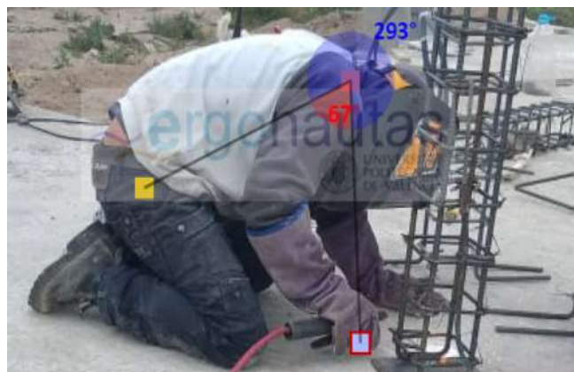
Figura 31. Medición del ángulo del brazo (Muro de cimentación) Elaborado por: Karen Villafuerte Fuente: (Ergonautas, 2015).
