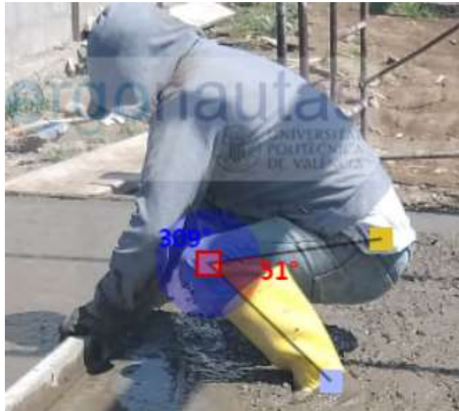
Figura 63. Medición del ángulo de las piernas (Fundición de loza de cimentación)
