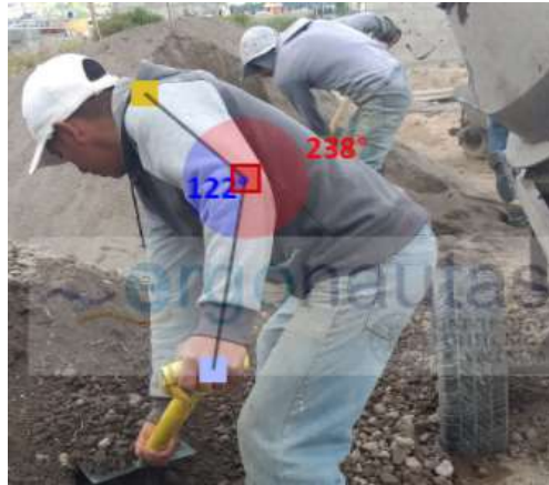
Figura 84. Medición del ángulo del antebrazo (Fundición de columnas)
