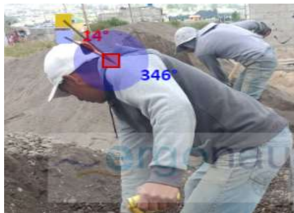
Figura 35. Medición del ángulo del cuello (Muro de cimentación) Elaborado por: Karen Villafuerte Fuente: (Ergonautas, 2015).
