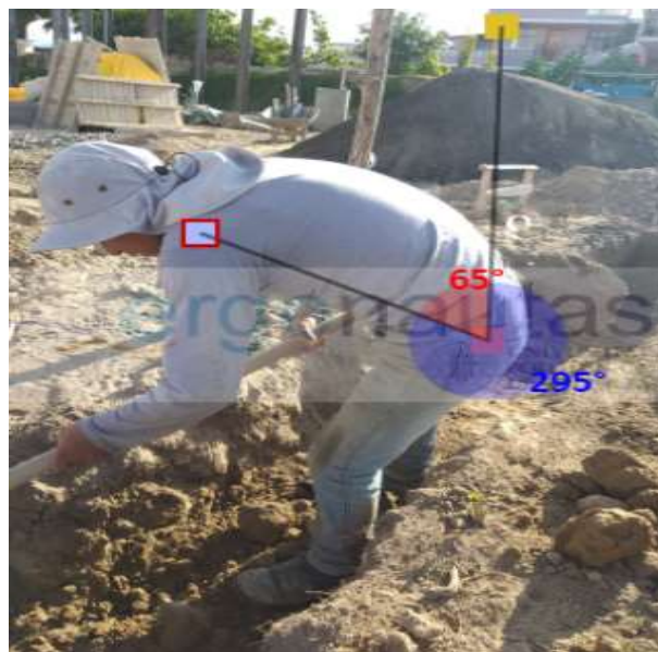
Figura 21. Medición del ángulo del tronco (Muro de cimentación)
