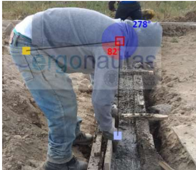
Figura 44. Medición del ángulo del brazo (Muro de cimentación)
