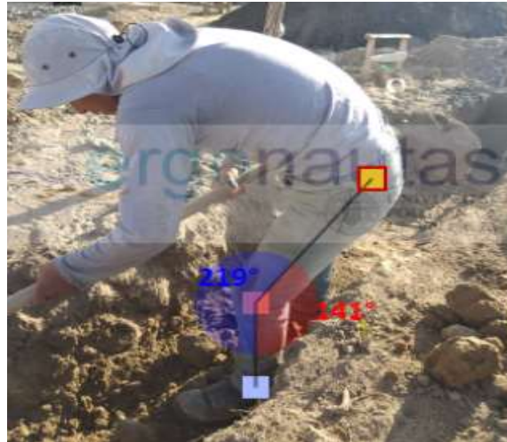
Figura 24. Medición del ángulo de las piernas (Muro de cimentación) Elaborado por: Karen Villafuerte Fuente: (Ergonautas, 2015).
