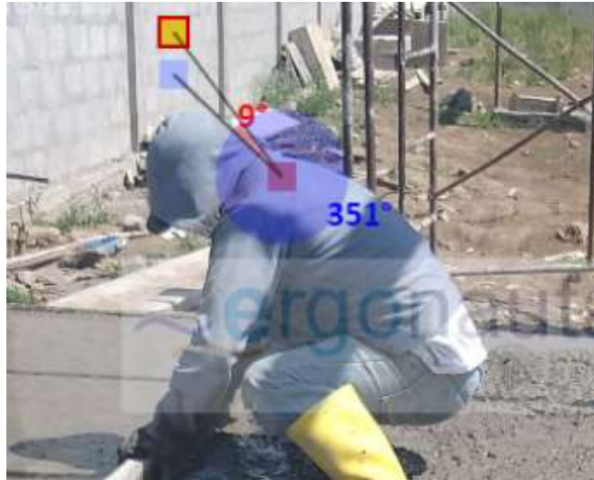
Figura 61. Medición del ángulo del cuello (Fundición de loza de cimentación) Elaborado por: Karen Villafuerte Fuente: (Ergonautas, 2015).
