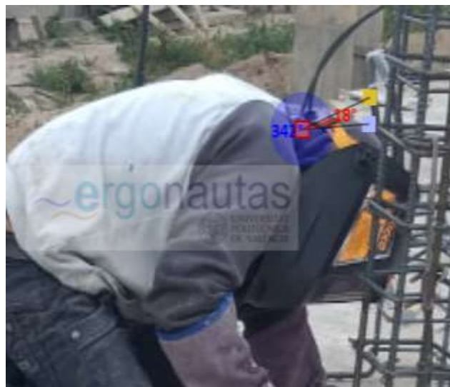
Figura 29. Medición del ángulo del cuello (Muro de cimentación)
