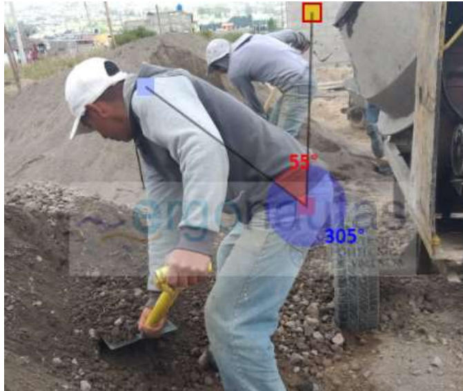
Figura 80. Medición del ángulo del tronco (Fundición de columnas) Elaborado por: Karen Villafuerte Fuente: (Ergonautas, 2015).
