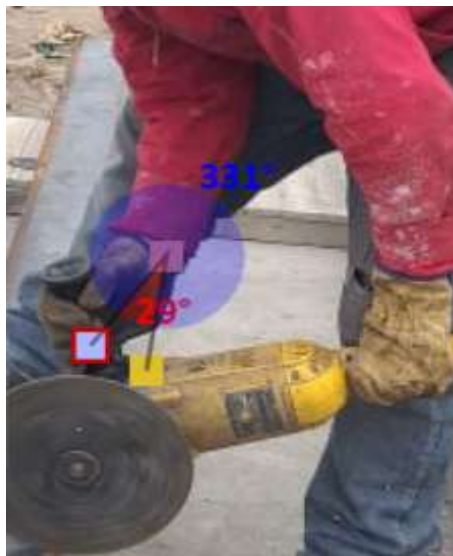
Figura 72. Medición del ángulo de la muñeca (Armado de estructura) Elaborado por: Karen Villafuerte Fuente: (Ergonautas, 2015).
