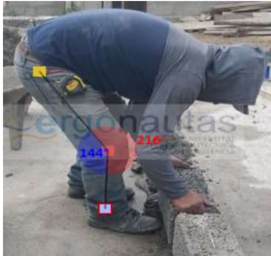
Figura 100. Medición del ángulo de las piernas (Levantamiento de paredes) Elaborado por: Karen Villafuerte Fuente: (Ergonautas, 2015).
