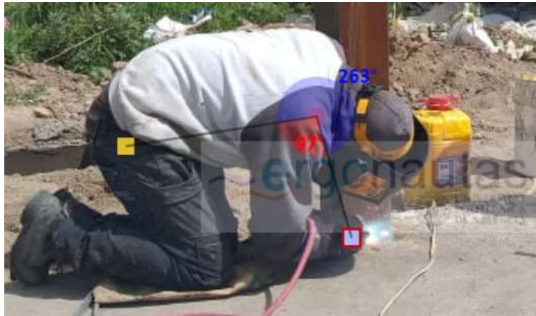
Figura 77. Medición del ángulo del brazo (Armado de estructura)
