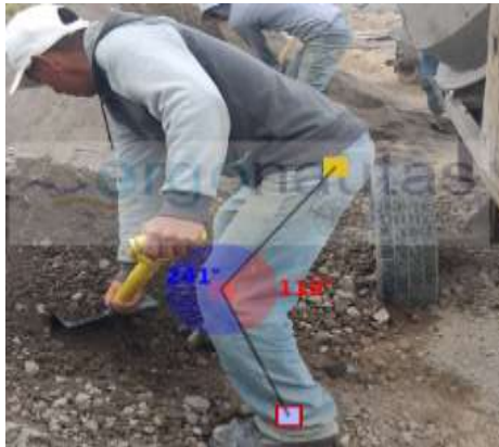
Figura 82. Medición del ángulo de las piernas (Fundición de columnas)
