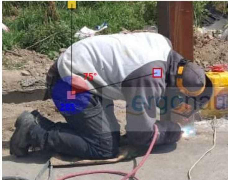
Figura 73. Medición del ángulo del tronco (Armado de estructura)
