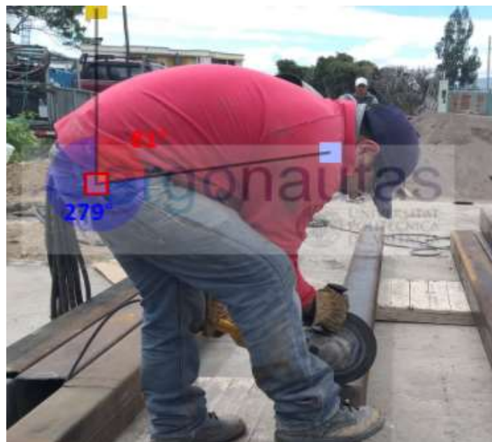
Figura 67. Medición del ángulo del tronco (Armado de estructura)
