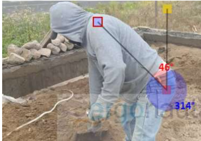
Figura 48. Medición del ángulo del tronco (Nivelación del terreno) Elaborado por: Karen Villafuerte Fuente: (Ergonautas, 2015).
