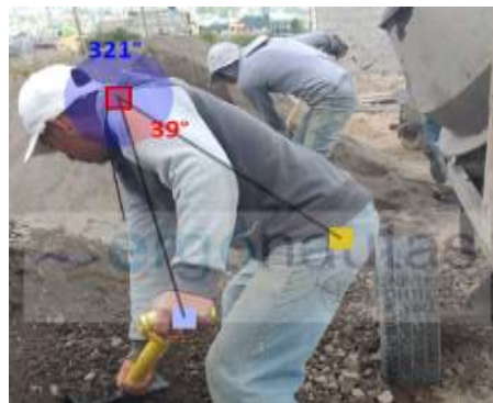
Figura 83. Medición del ángulo del brazo (Fundición de columnas)
