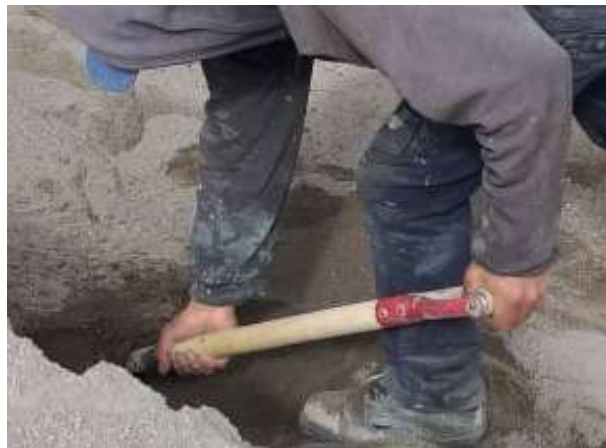
Figura 85. Medición del ángulo de la muñeca (Fundición de columnas)
