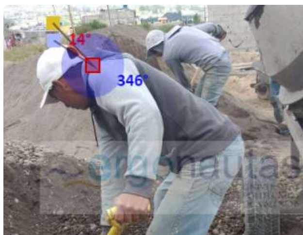
Figura 55. Medición del ángulo del cuello (Fundición de loza de cimentación)
