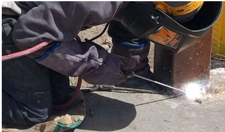
Figura 79. Medición del ángulo de la muñeca (Armado de estructura)
