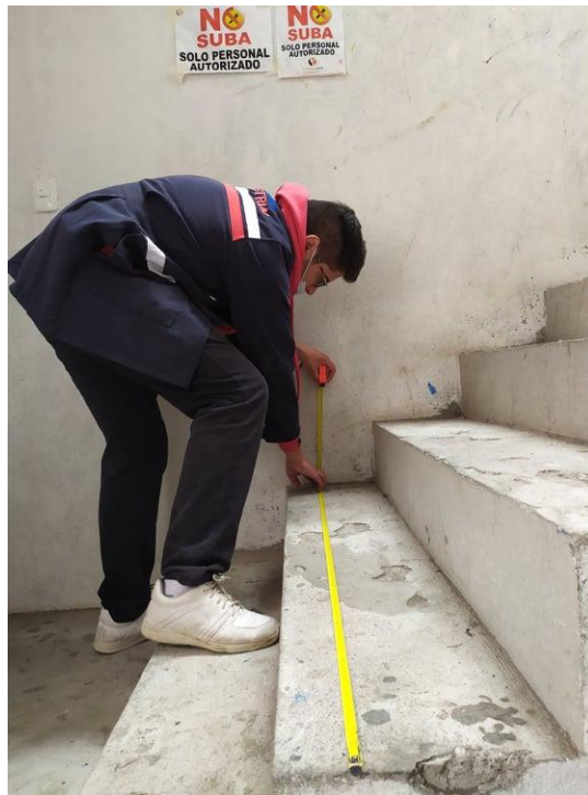
Imagen 19: Medición para enmarcaje de pisos
