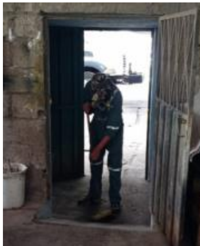
Imagen 13. Preparación del piso para pintar. Fuente: A. Hurtado, 2021
