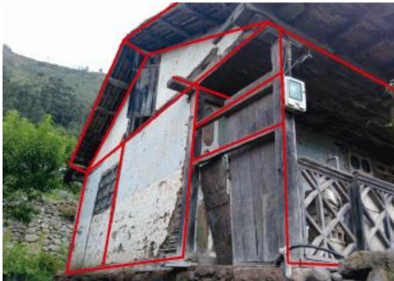
**Imagen 74. Componente Estructura de Madera (Vivienda N.- 02 - Patate)**
