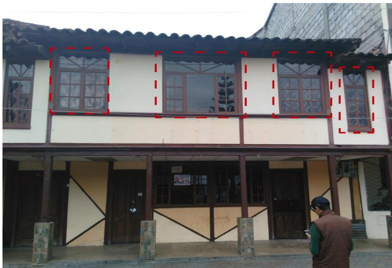
**Imagen 81. Conservación de Ventanas e Implementación de Contrapuertas de Acero**
