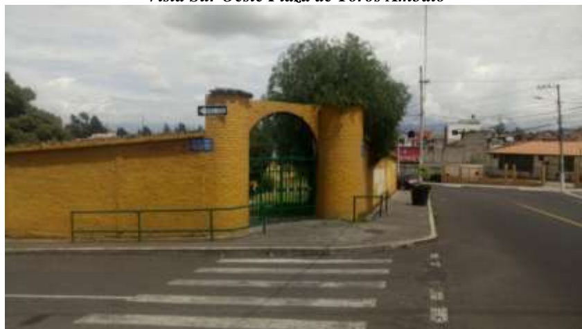
Figura 64. Vista Sur Oeste Plaza de Toros Ambato
