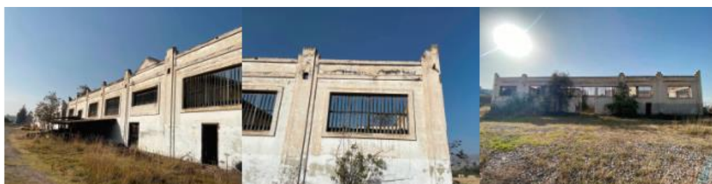
Imagen 21. Base de mantenimiento del tren, bloque 1
