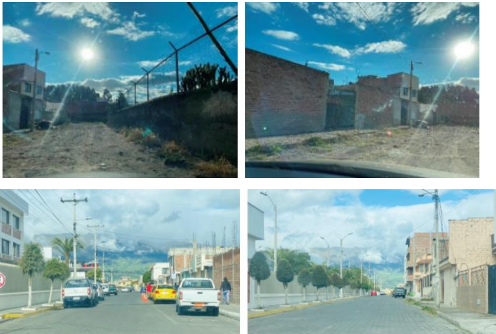
Imagen 17. Carencia de infraestructura de la Calle Esmeraldas
