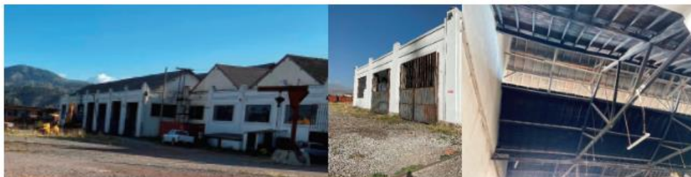
Imagen 22. Base de mantenimiento del tren, bloque 2
