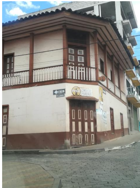
Ilustración 26: Estado REGULAR de la Vivienda
