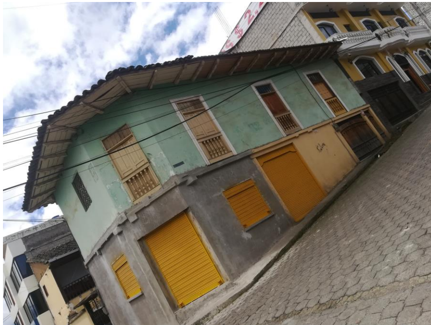
Ilustración 29: Implementación de Hormigón en fachada de la Vivienda Patrimonial. Elaboración: Propia
