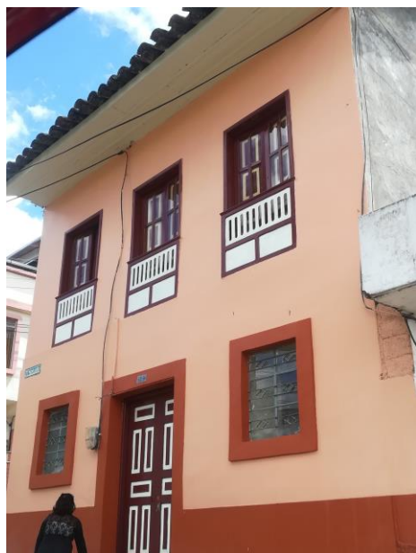
Ilustración 25: Estado BUENO de la Vivienda P. P.
