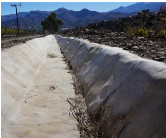
Revestimiento de canal
