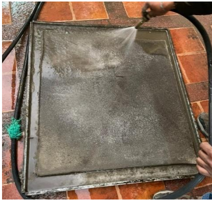
Humedecimiento de mantos de hormigón
