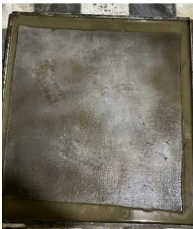
Reposo de manto de hormigón
