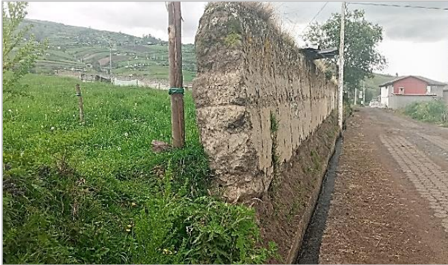
Figura 18: Mampostería de tapial
