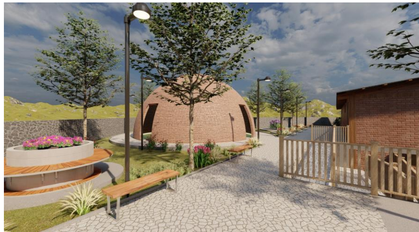
Figura 79. Observatorio - vista exterior Elaboración propia
