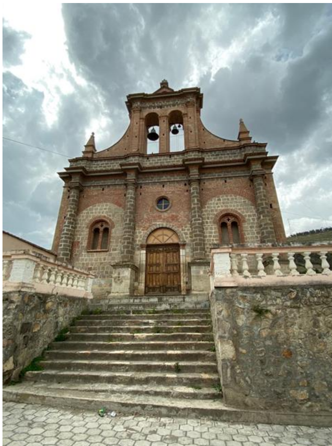
Figura 10. Iglesia Central – Fachada Frontal Elaboración propia
