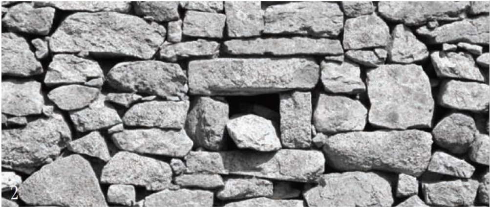
Figura 12. Muro de fábrica de piedra, detalle de ventana.
