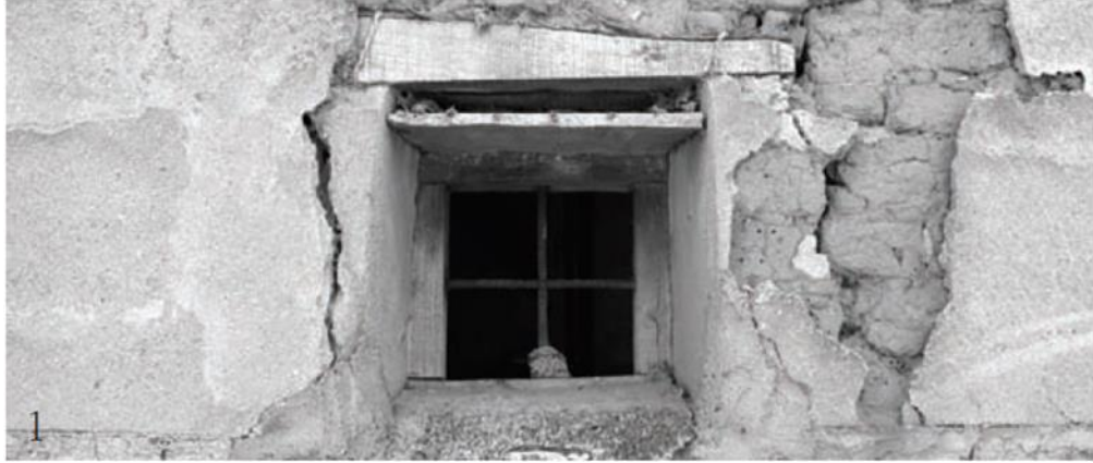
Figura 11. Muro de fábrica de adobe, detalle de ventana
