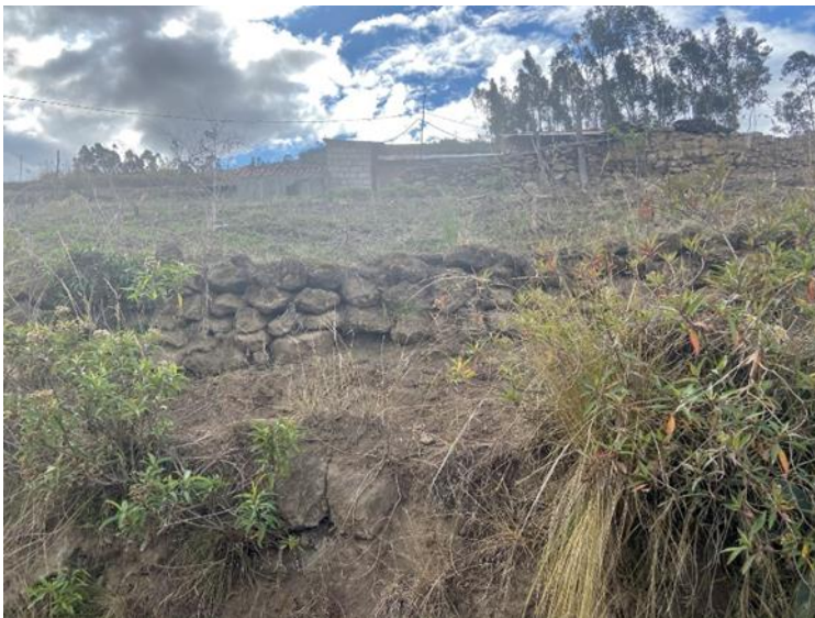
Figura 13. Muro de piedra ubicado en Bacún
