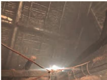
Desgaste de los materiales de la cubierta producido por el hollín que produce la cocina de leña.
