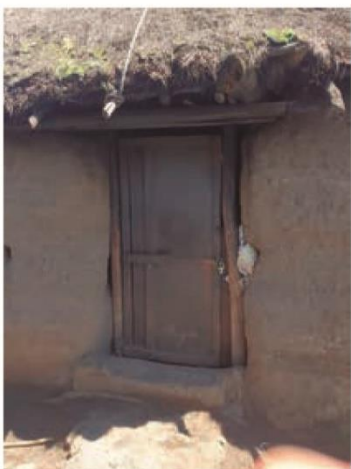
Refuerzo en dintel para la colocación de la puerta de ingreso.
