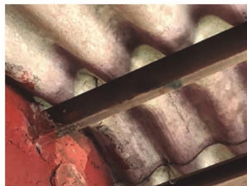
Materiales utilizados en la conformación de la cubierta con planchas de fibrocemento y largueros de metal.
