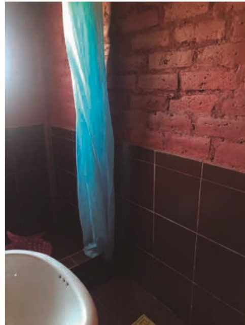
Recubrimiento de cerámica en baño para evitar el paso de humedad exterior.
