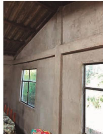
Paredes internas con revocado de hormigón realizado por la dueña de la vivienda.
