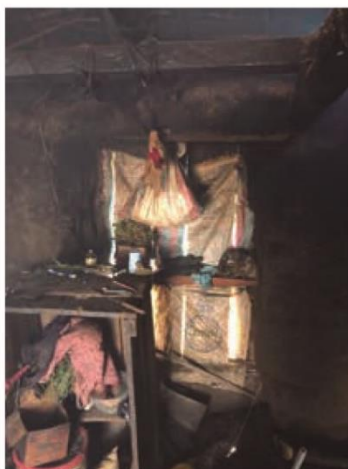
Puerta posterior de la vivienda, que es obstruida con enceres.
