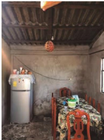
Comedor de la vivienda con paredes con revocado.
