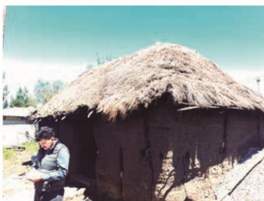
Cubierta de paja con madera rolliza y paredes de adobe sin sobrecimiento.
