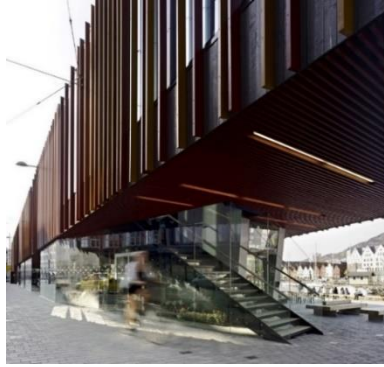
Imagen 7. Estructura - Mercado Bergen, Noruega
