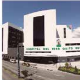
HOSPITAL DEL IESS SUR
