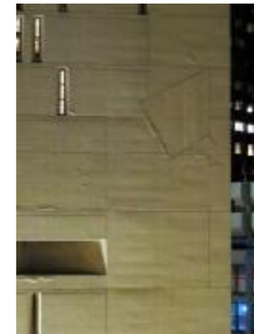
Ilustración 39. Mampostería de Ladrillo
