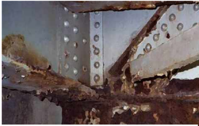
Imagen 19 Corrosión
