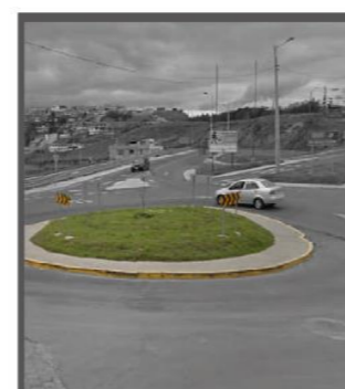
EL REDONDEL Y TUNEL DE GUAJALO ES LA PRINCIPAL CONEXIÓN ENTRE BARRIOS DE LA ARGELIA Y TAMBIÉN ES EL PRINCIPAL RETORNO PARA EL NORTE DE QUITO
