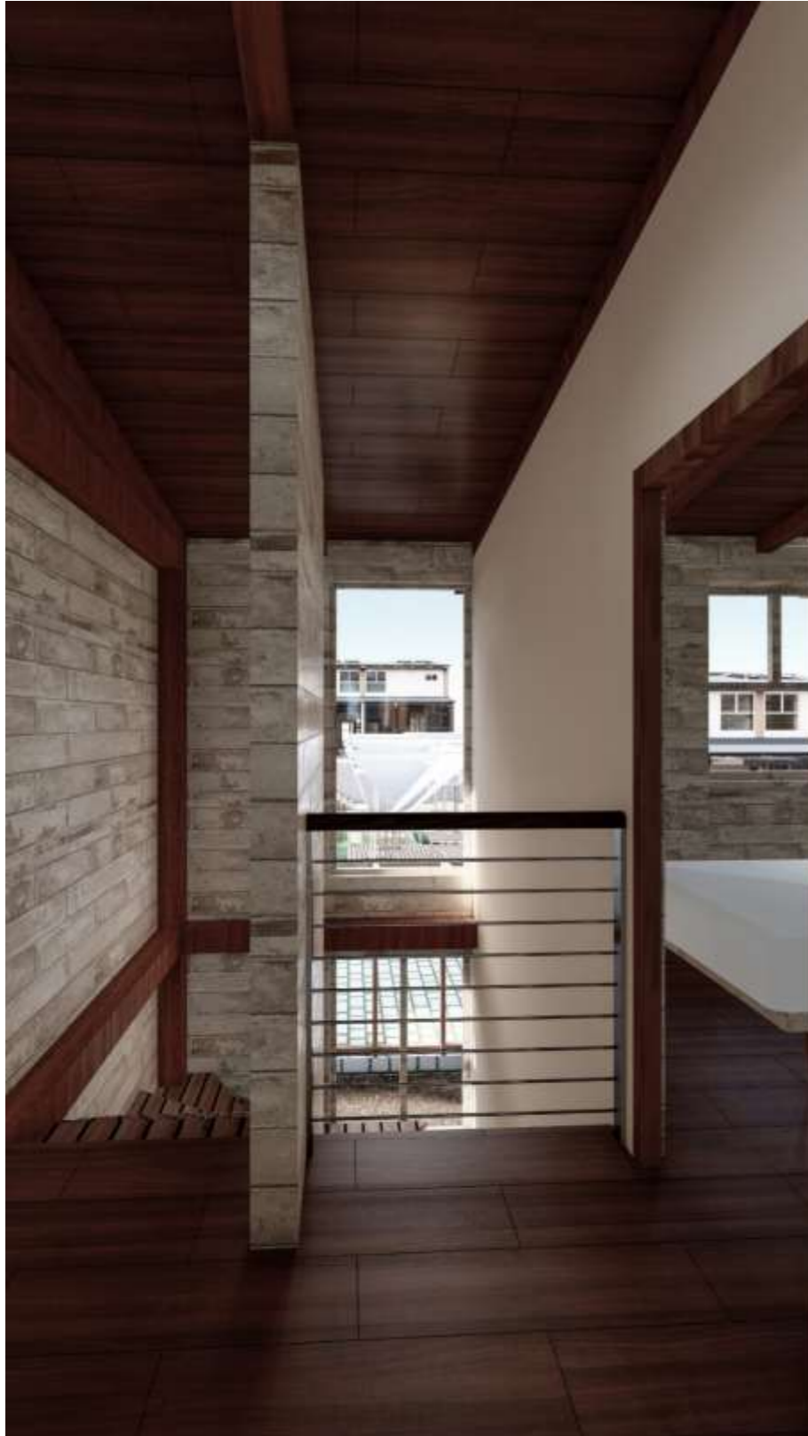
Calentamiento de muro térmico en el interior de la vivienda
