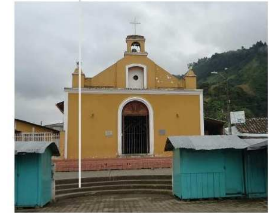
VANOS ENMARCADOS PLAZA CON GRADERÍO
