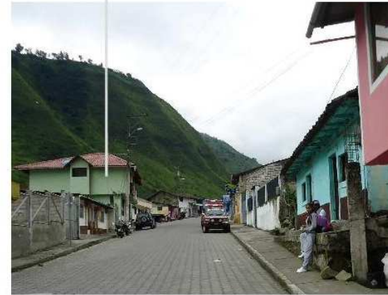
COLORES VIVOS EDIFICACION TECNTONICA
