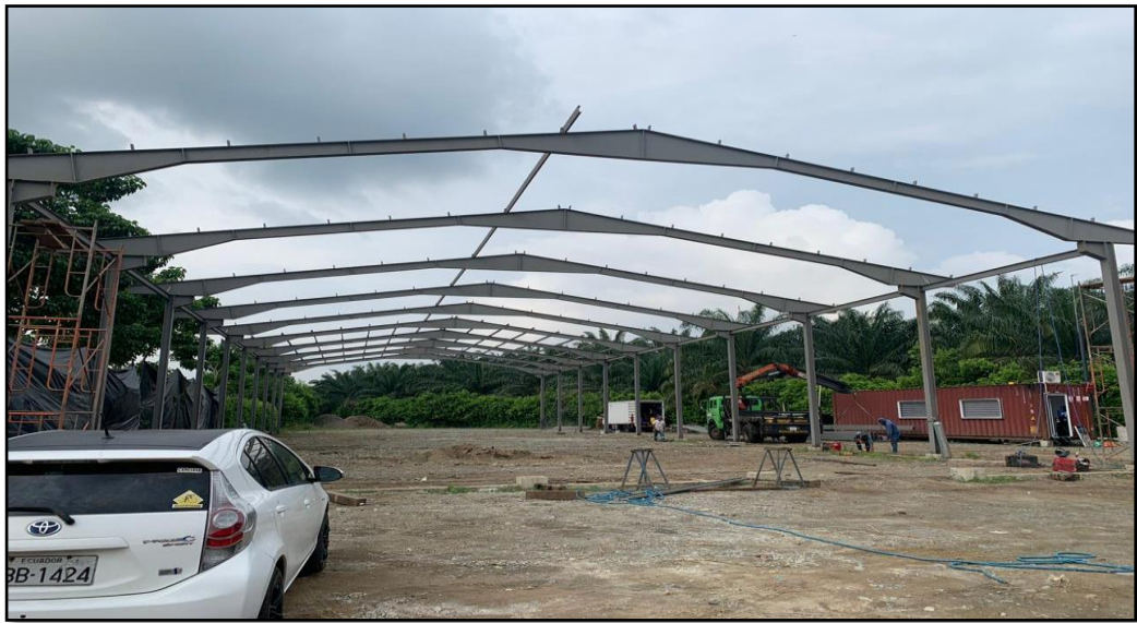
Imagen 5.- Montaje estructural Fuente: (Steel Estructuras, 2015)
