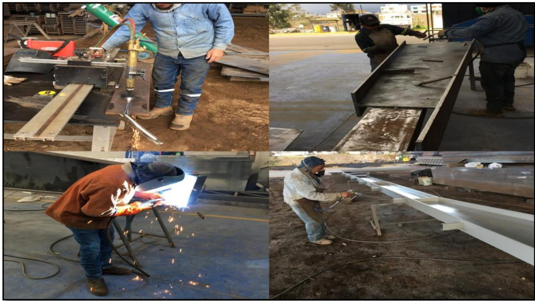
Imagen 4.- Corte, armado, soldado y pintura de la estructura Fuente: (Steel Estructuras, 2015)
