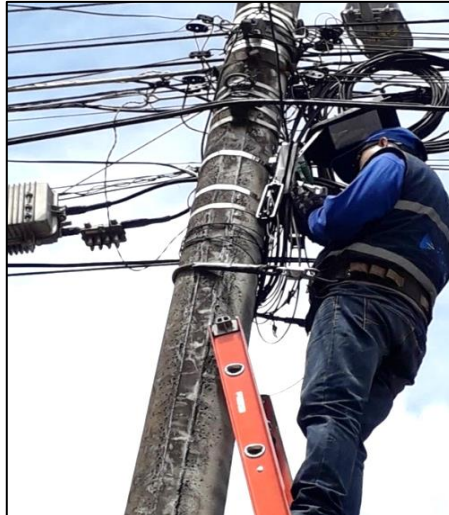
Imagen 3. Colocación de conectores en el poste e instalación en el Tap.
