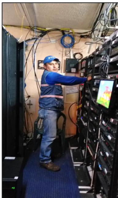
Imagen 4. Mantenimiento de equipo de telecomunicaciones de Cablepremier S.A.
