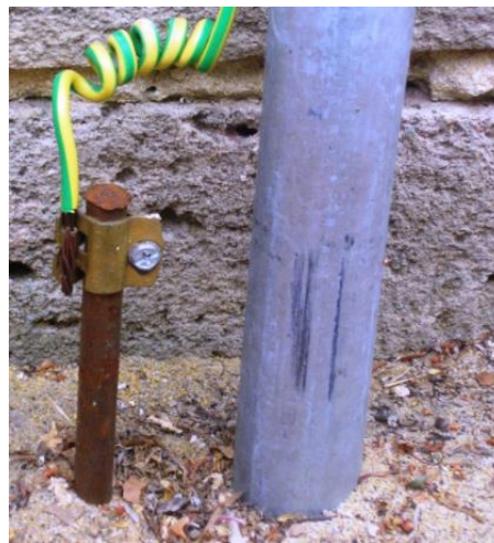
Imagen 19. Colocación de tierra
