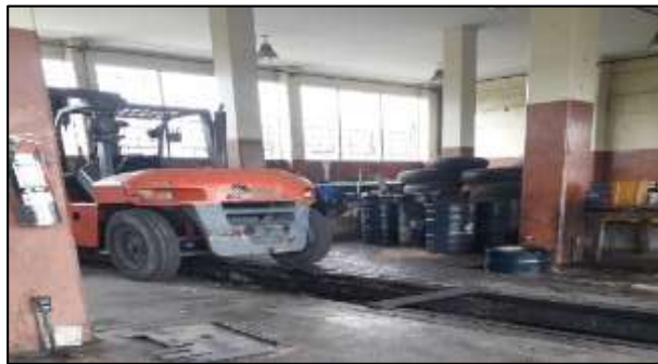
Imagen 1: Área de rampas del taller de mantenimiento de APE. Fuente: Autoridad Portuaria de Esmeraldas.
