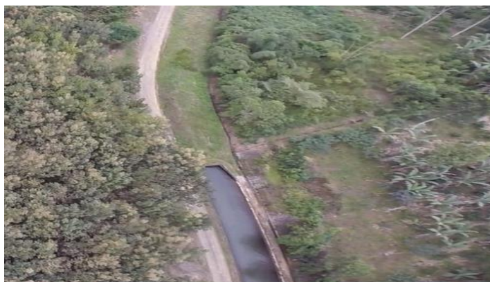
Imagen 2: Canal Abierto y Embaulado Fuente: Central Hidroeléctrica Sibimbe
