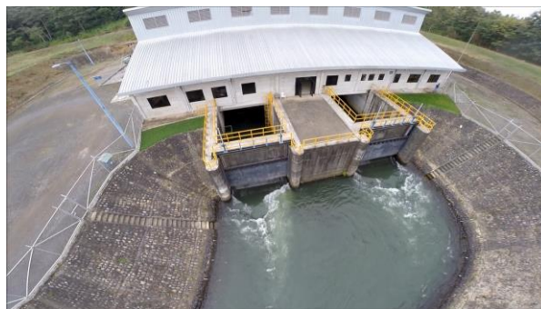
Imagen 13: Canal de reposición al río Fuente: Central Hidroeléctrica Sibimbe
