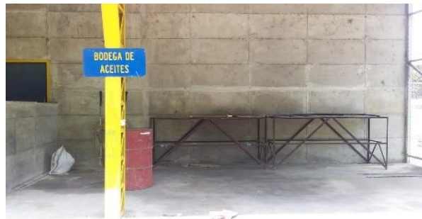
Imagen 26: Bodega de aceites Fuente: Central Hidroeléctrica Sibimbe
