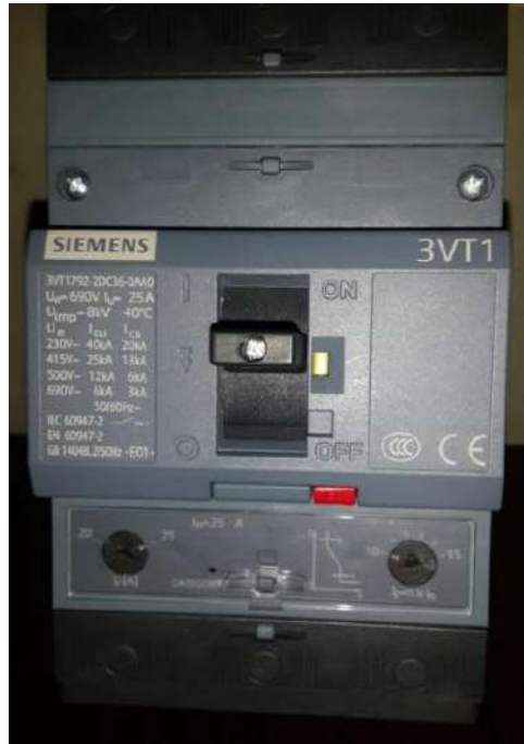
Imagen 10. Breaker Siemens 3vt1 Elaborado por: Pazmiño (2019)
