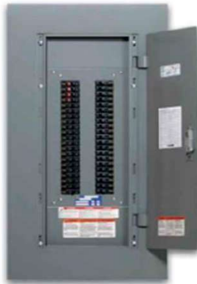
Imagen 12. Tablero de Distribución
