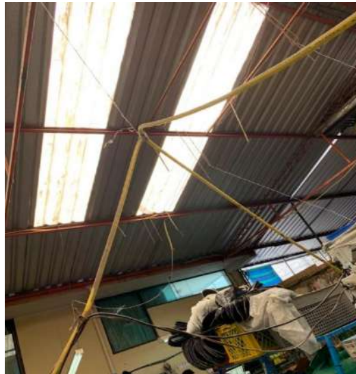
Imagen 5. Conexiones neumáticas Elaborado por: Pazmiño (2019)
