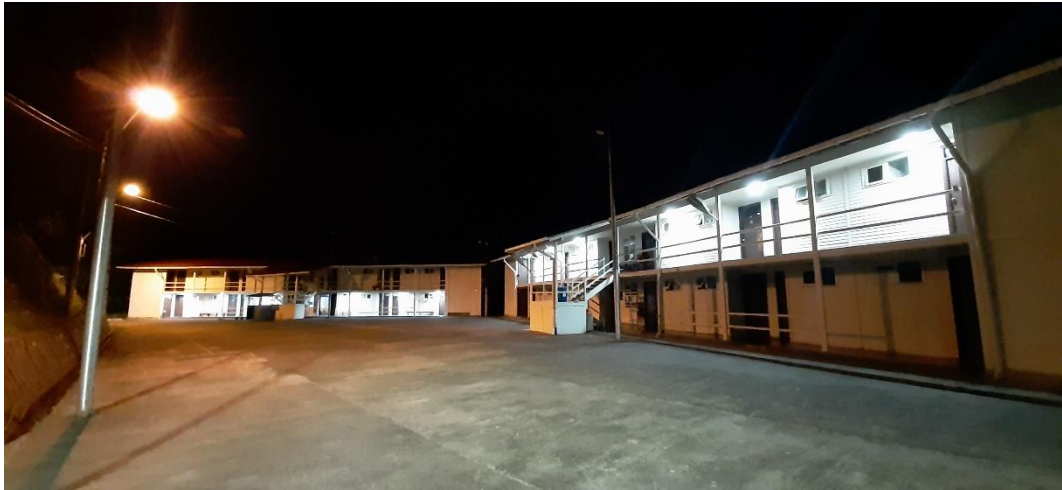
ILUMINACIÓN NO CONTROLADA
