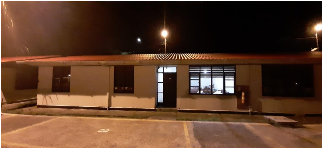
ILUMINACIÓN NO CONTROLADA
