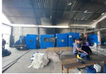
FACHADA LAT IZQUIERDA (INTERNA)
