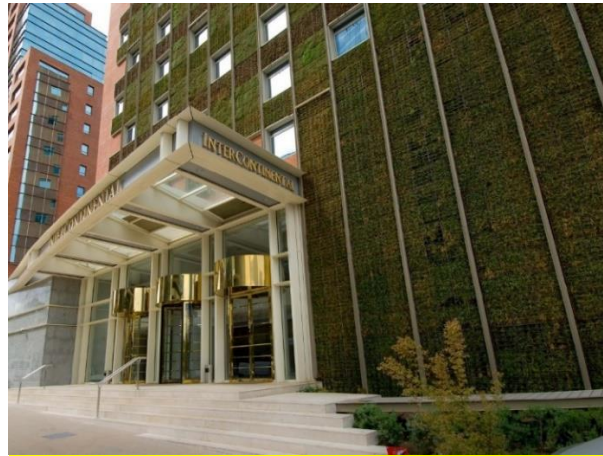
Ilustración 41: Malla y perfilería del Jardín Verde Fuente: Aleparte, Wedeles, Barreda y Besançon (2011)
