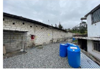
FACHADA LAT DERECHA
