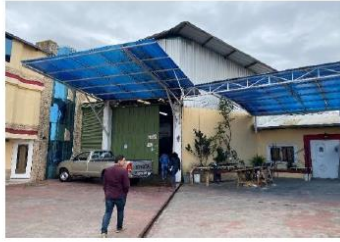
FACHADA LAT DERECHA
