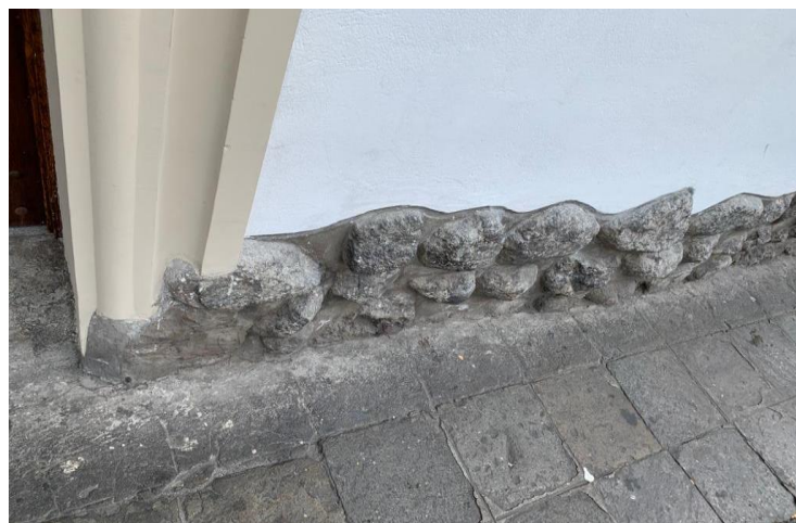
Fotografía 99. Cimentación de piedra molón Fuente: Taipe, Santiago (2020)
