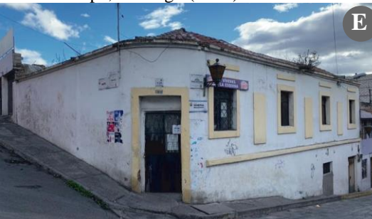
Fotografía 29. Cubierta tipo E, calle Napo y General Maldonado
