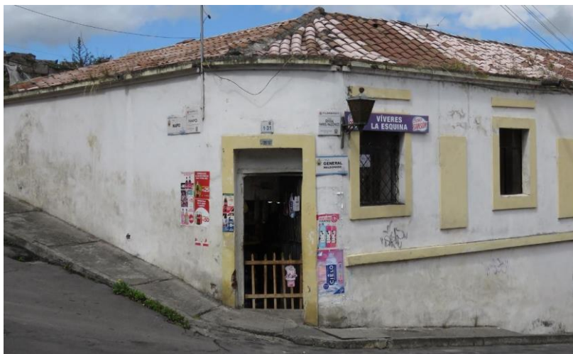
Fotografía 76. Vivienda patrimonial ubicado en la calle Napo y General Maldonado Fuente: Taípe, Santiago (2020)
