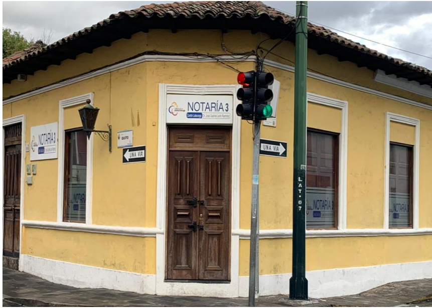
Fotografía 10. Vivienda tradicional ubicada en San Agustín Fuente: Taipe, Santiago (2020)
