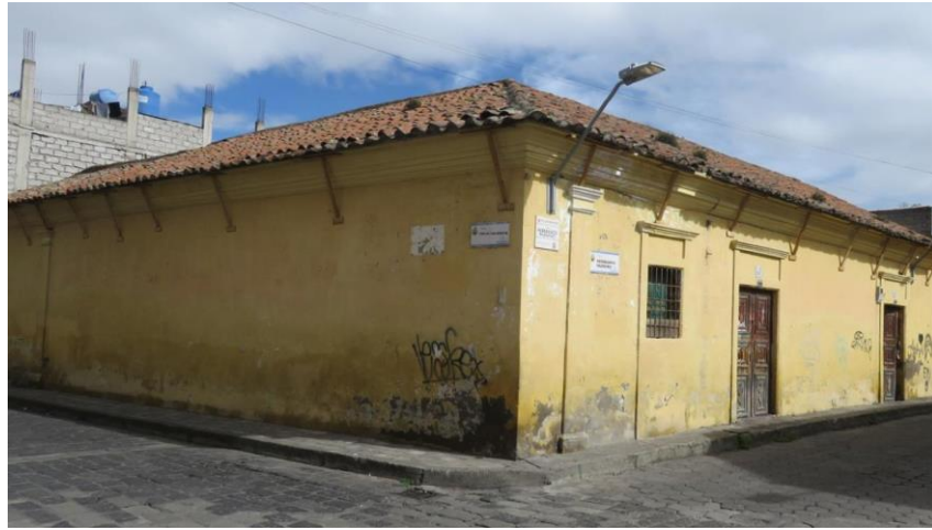
Fotografía 73. Vivienda patrimonial estilo neocolonial ubicado en la Av. Félix Valencia y Hermanos Pazmiño
