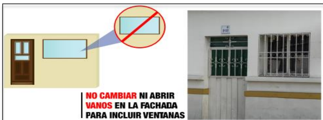
Gráfico 53. Inadecuada intervención en ventanas Elaborado por: Taipe, Santiago (2020)
