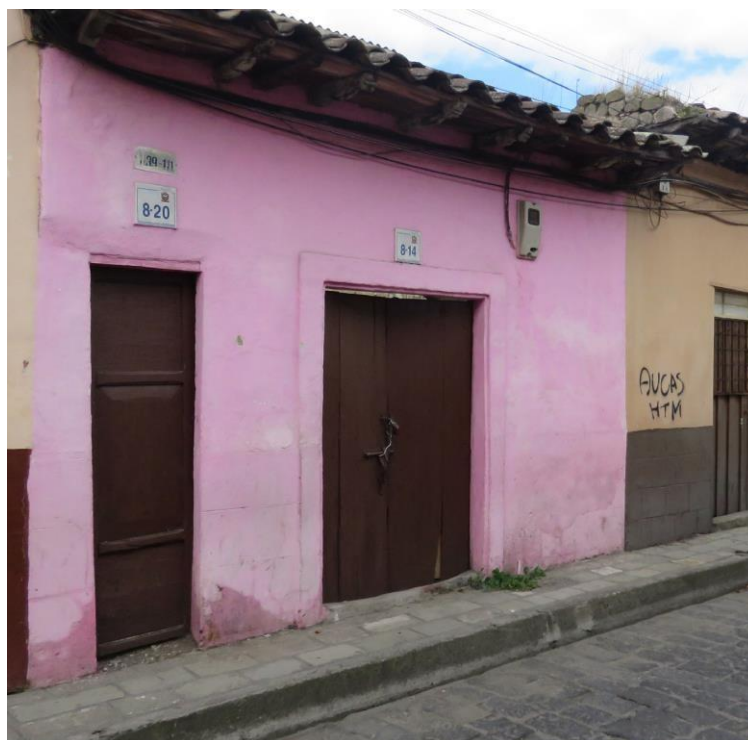
Fotografía 79. Vivienda patrimonial ubicada en la calle Guayaquil y Hermanas Pazmiño, Latacunga
