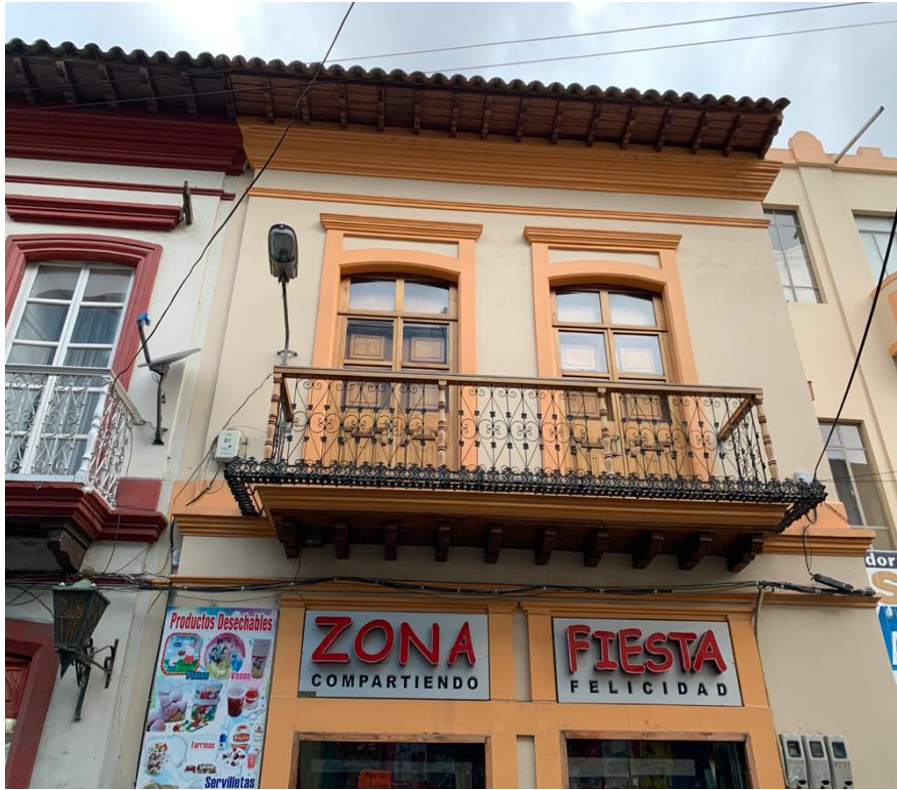
Fotografía 123. Balcones en fachadas patrimoniales
