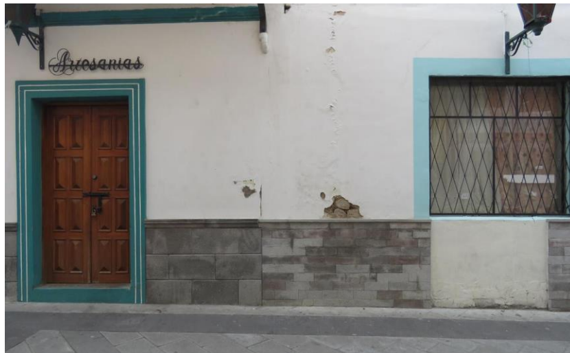
Fotografía 85. Enchapes en fachadas de carácter patrimonial Fuente: Taipe, Santiago (2020)
