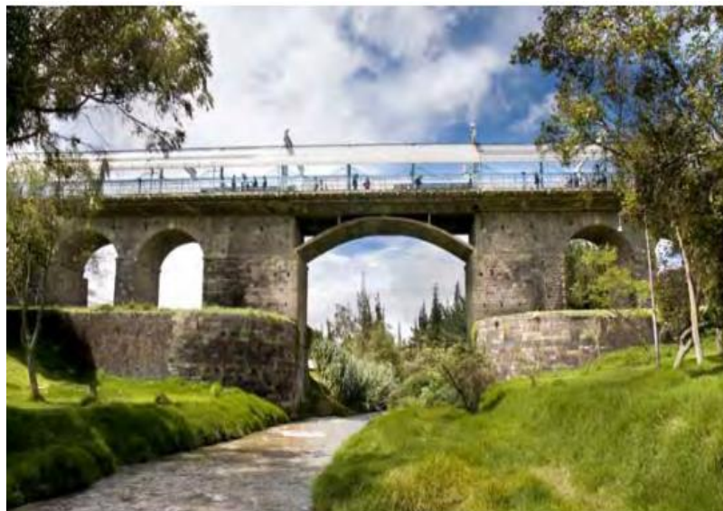
Fotografía 4. Puente sobre el río Cutuchi. Latacunga
