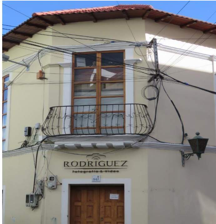
Fotografía 126. Cableado público sobre fachada patrimonial Fuente: Taipe, Santiago (2020)
