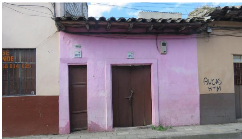
Fotografía 108. Muro de adobe en fachadas patrimoniales Fuente: Taípe, Santiago (2020)
