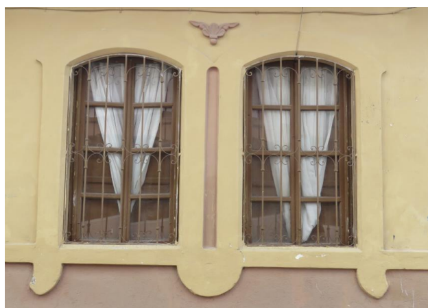
Fotografía 122. Ventanas en fachadas de viviendas patrimoniales Fuente: Taipe, Santiago (2020)
