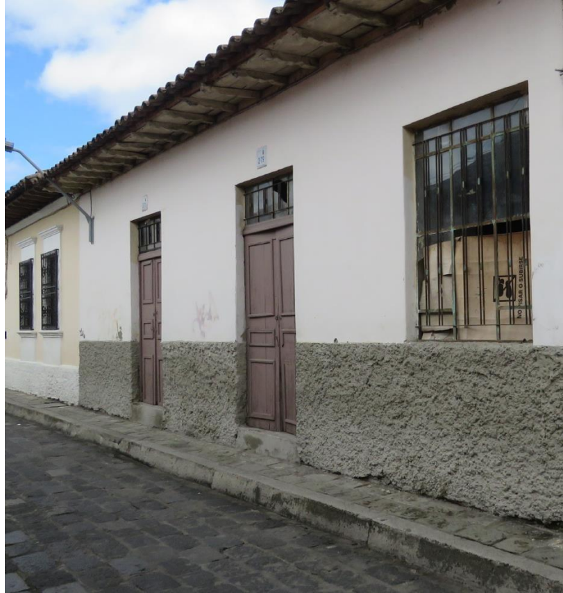
Fotografía 68. Fachada de vivienda patrimonial ubicada en la Av. Hermanas Pazmiño y Félix Valencia Elaborado por: Taipe, Santiago (2020)
