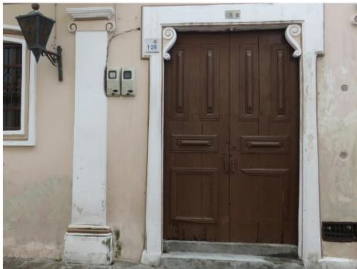
Fotografía 119. Portada original de vivienda patrimonial Fuente: Taipe, Santiago (2020)
