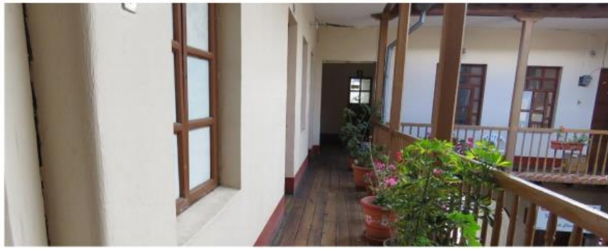
Fotografía 62. Pasillo de casa patrimonial ubicada en la calle Guayaquil y Quito Elaborado por: Taipe, Santiago (2020)
