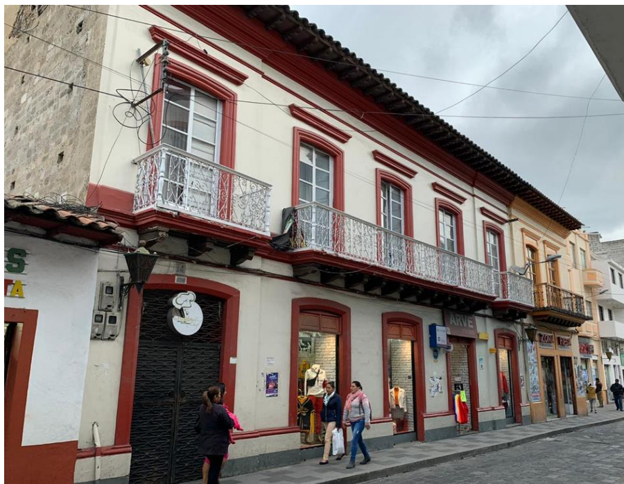
Fotografía 43. Vivienda intervenida en la parroquia La Matriz Elaborado por: Taípe, Santiago (2020)
