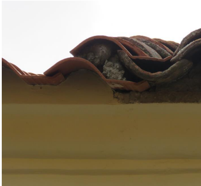
Fotografía 67. Tejas de acero y tejas de barro superpuestas Elaborado por: Taipe, Santiago (2020)
