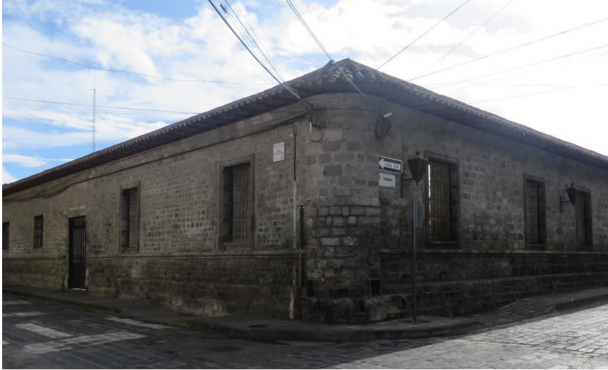
Fotografía 91. Inmueble inventariado de carácter patrimonial ubicado en la Av. Tarqui y Fernando Sánchez de Orellana Fuente: Taipe, Santiago (2020)
