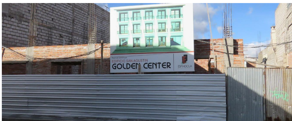
Fotografía 69. Restitución de vivienda patrimonial ubicada en la plazoleta de San Agustín Elaborado por: Taipe, Santiago (2020)
