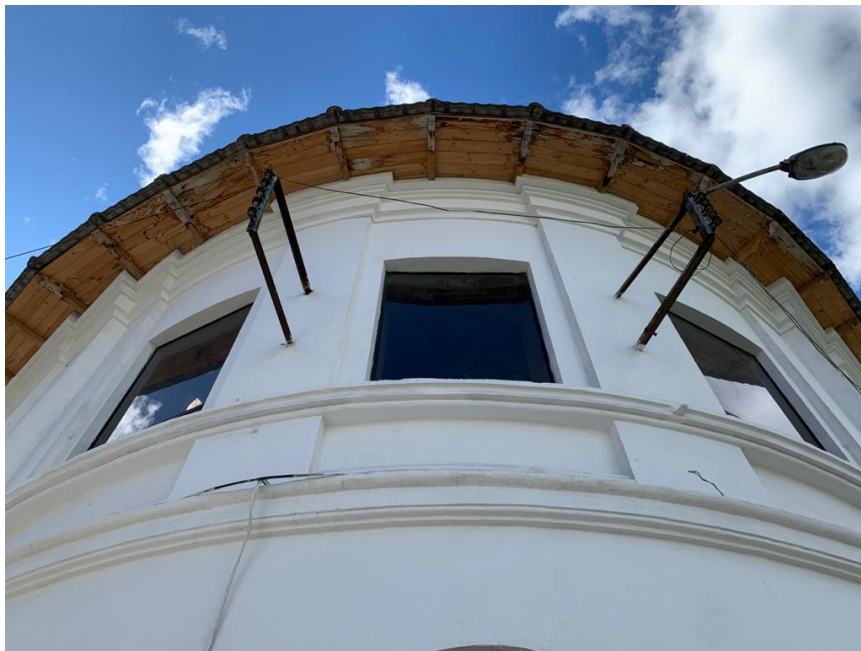
Fotografía 125. Aleros en vivienda patrimonial
