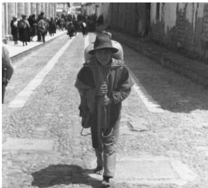
Fotografía 54. Calle General Maldonado Fuente: (Horts, 1930)
