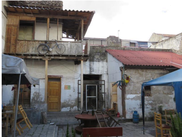
Fotografía 103. Interior de vivienda patrimonial Fuente: Taipe, Santiago (2020)
