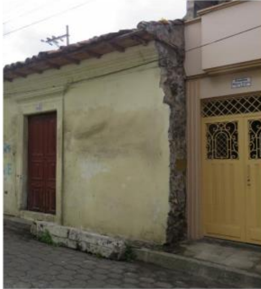
Fotografía 64. Fachada de vivienda patrimonial ubicada en la Av. Hermanas Pazmiño y Calixto Pino Elaborado por: Taipe, Santiago (2020)
