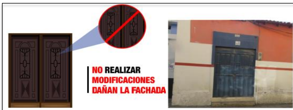
Gráfico 50. Inadecuada intervención en puertas
