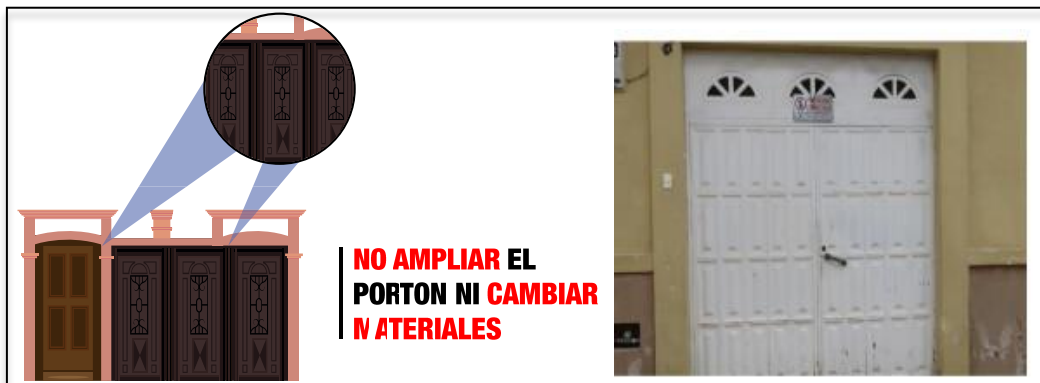
Gráfico 47. Inadecuada intervención en portadas Elaborado por: Taipe, Santiago (2020)
