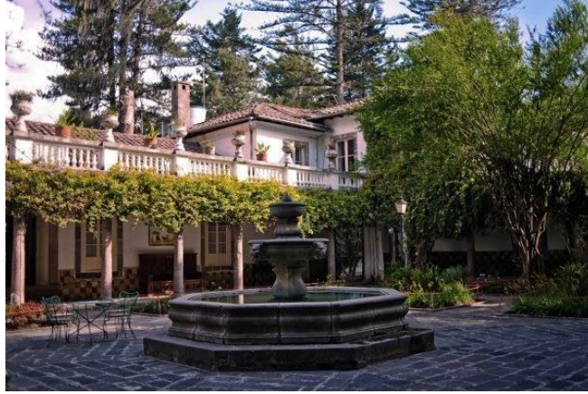
Ilustración 18. Casa de Hacienda la Balbina Fuente: http://losladrillosdequito.blogspot.com
