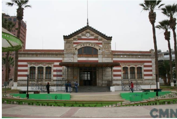
Ilustración 10. Edificio Ex Aduana de Arica, Centro Cultural Fuente: https://issuu.com/mop_chile0/docs/15_proyectos_de_restauraci_n
