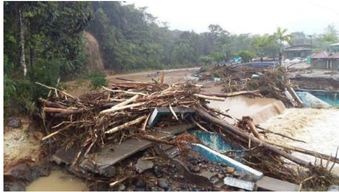
Figura 4. Dstrucción -Dique Shell, 2016
