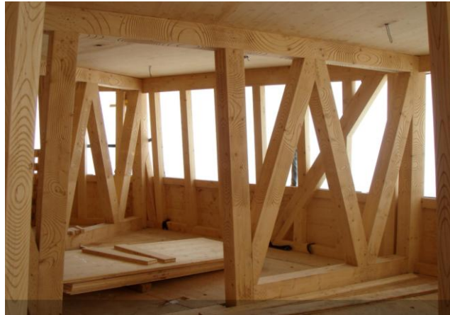
Imagen 16: Perspectiva de los muros de apoyo integrales
