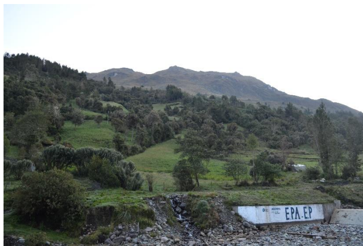
Ilustración 2: punto de recolección de agua el Bocatoma
