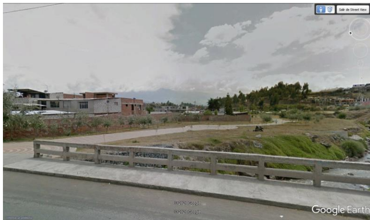
Imagen N°14: Puente del sector Barrio La Primavera, Río Chibunga Fuente: Google Earth
