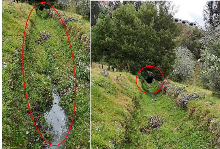
Imagen N°28: Punto de desfogue de aguas residuales y aguas servidas Fuente: Jaime Andrés Fiallos
