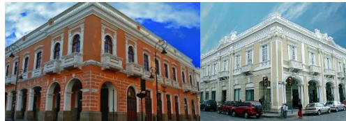
Edificio de la gobernación
