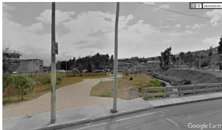
Imagen N°12: Puente del sector Barrio La Primavera, Río Chibunga Fuente: Google Earth
