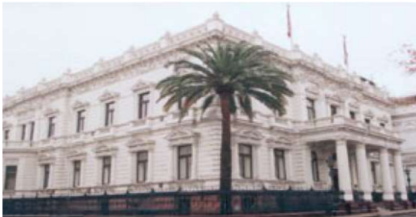
Imagen 10. Ex Palacio de Septiembre– Chile. Fuente: Procade, (2012).
