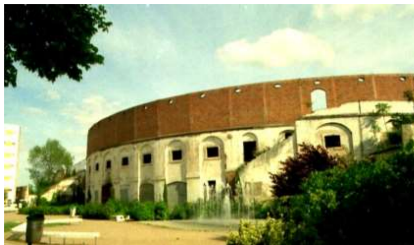
Imagen 73. Plaza de toros ronda del pilar- estado de deterioro. Fuente: Alba Temperan, (2015).
