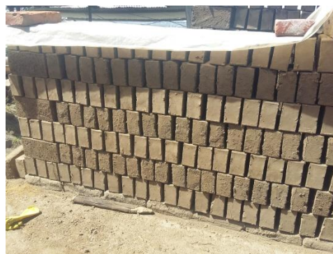
Imagen 18: Vivienda mixta de adobe y ladrillo Fuente: María José Olalla
