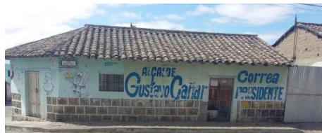
Imagen 50: zócalo de piedra Fuente: Elaboración propia
