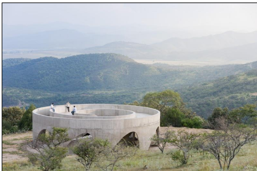
Imagen 1: Mirador Espinazo del diablo, México Fuente: (Plataforma Arquitectura, 2011)
