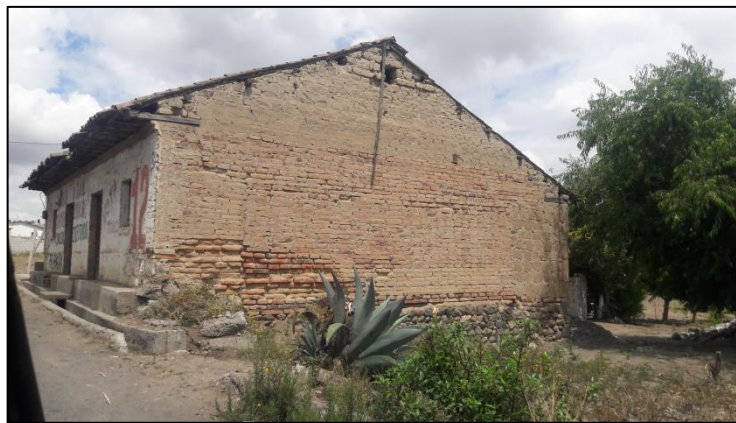
Imagen 14: Vivienda mixta de adobe y ladrillo Fuente: María José Olalla
