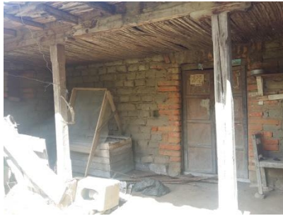
Imagen 49: Casa de mezcla de materiales adobe y ladrillo Fuente: Elaboración propia
