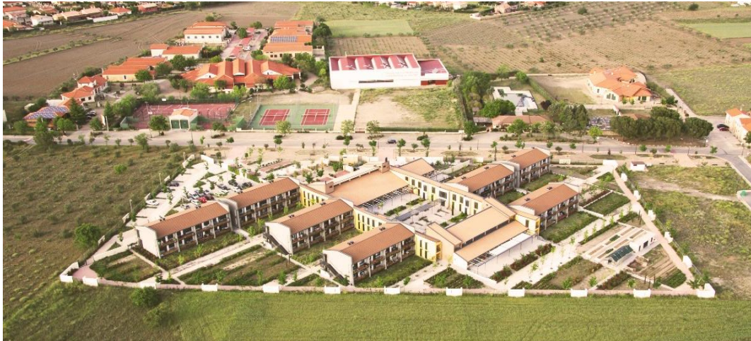
Imagen 17: Centro social de convivencia, asistencia y servicios para mayores, Trabensol Fuente: (Plataforma de arquitectura, 2015)
