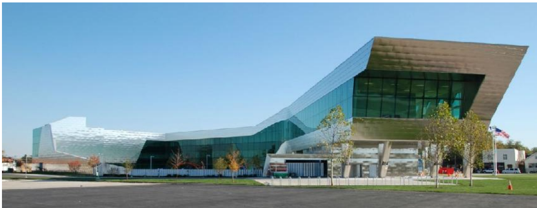
Imagen 73: Fachada principal del equipamiento deportivo UNO construido por IGMA arquitectos.
