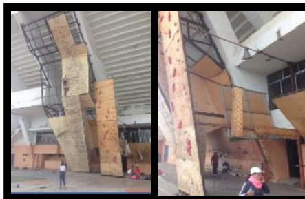
Imagen 60: Fotografía estado actual del espacio físico de entrenamiento de escalada, se puede apreciar el incumplimiento que requiere la norma.
