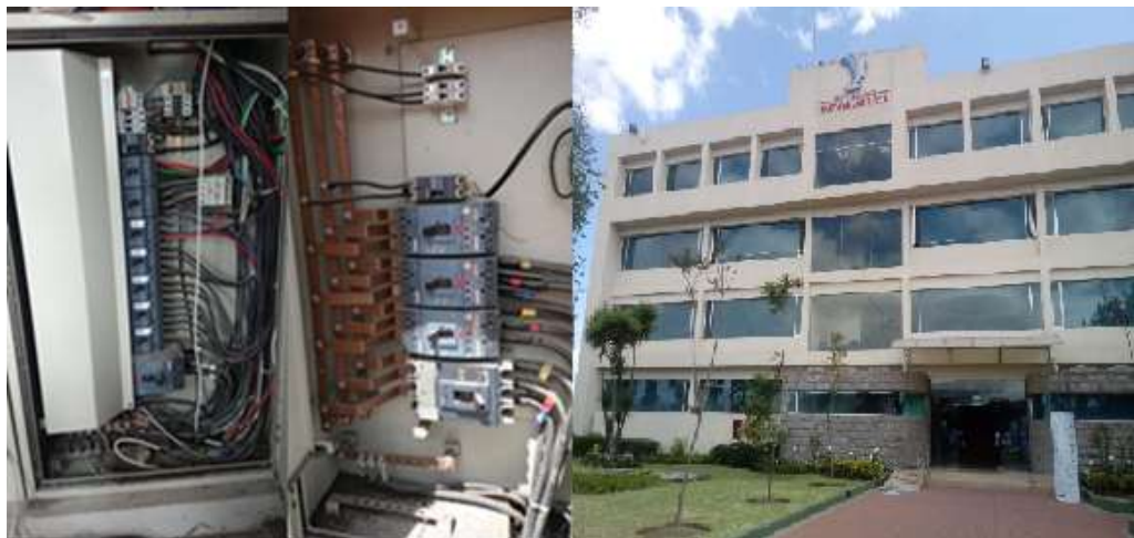
Imagen No 1: Cámara de abastecimiento principal Av. Machala Elaborado por: El Investigador
