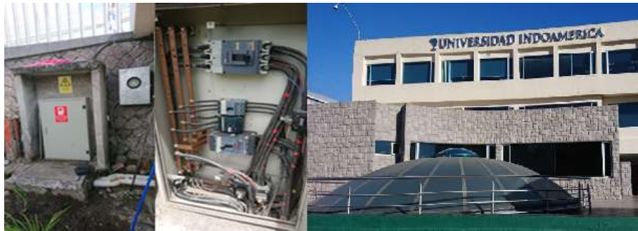
Imagen No 12: Cámara de abastecimiento principal T38355 Av. Sabanilla Elaborado por: El Investigador
