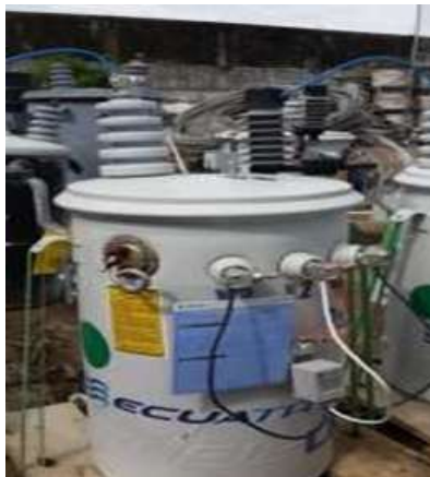
Gráfico No 15: Transformador auto-protegido
