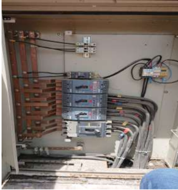
Gráfico No 10: Tablero general de la UTI Elaborado por: El Investigador
