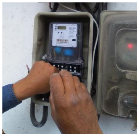
Figura 18: Reajuste de contactos en el medidor
