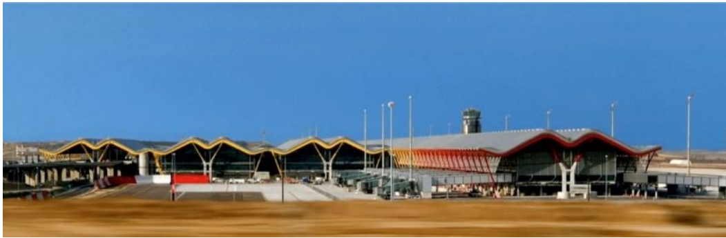
Gráfico 30. Vista exterior Terminal T4 Fuente. (Plataforma Arquitectura, 2019)
