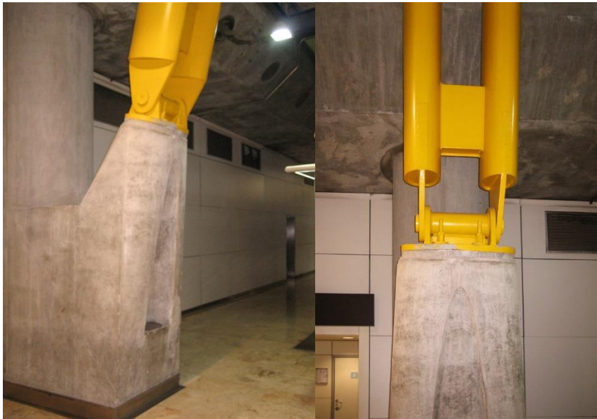
Gráfico 45. Detalles de unión estructural metálica en base de Hormigón armado. Fuente. Plataforma Arquitectura, 2019
