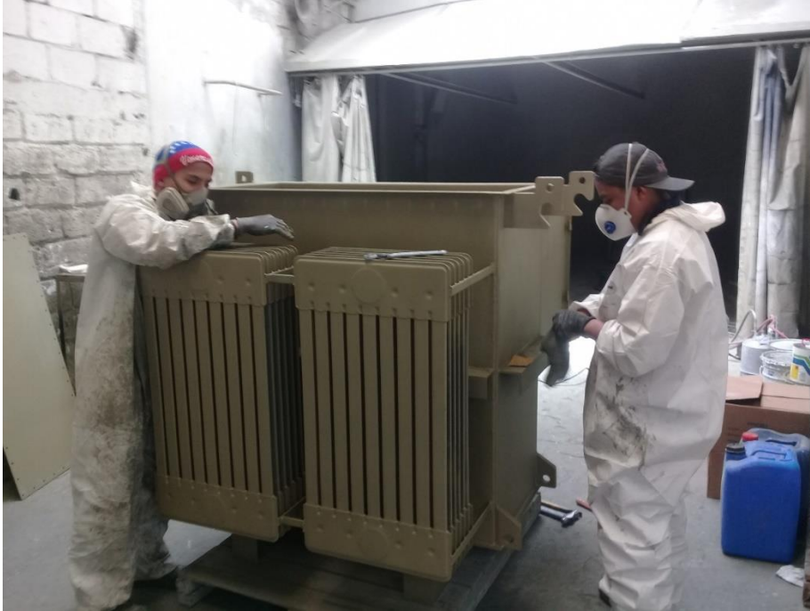
Figura 9 Preparación superficial del tanque
