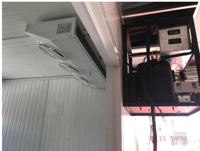
Figura 1.- Sistema de climatización unitario
